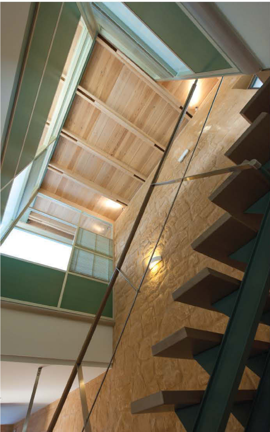
Η ελαφρύτερη κατασκευή του ορόφου εδράζεται πάνω στη λιθοδομή του ισόγειου.
